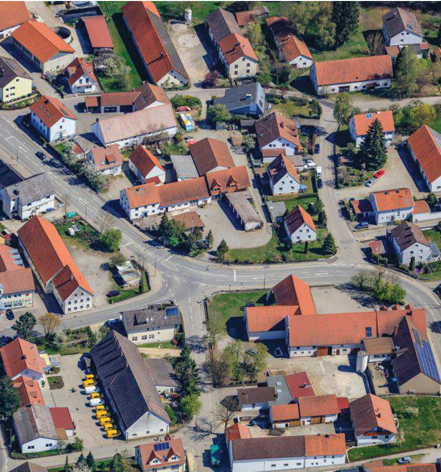
Das bauliche Gefüge an der Friedberger Straße
