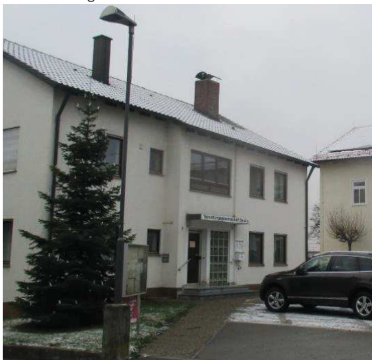
Öffentliche Verwaltungen: Rathaus (rechts) und VG-Gebäude
