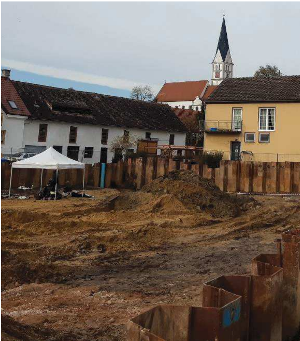
Taitinger Straße: Archäologische Grabungen – Römerstraße
