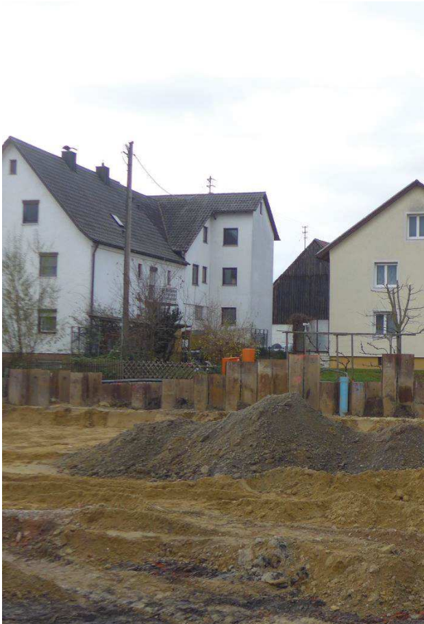
Taitinger Straße: Abbruchgrundstück
