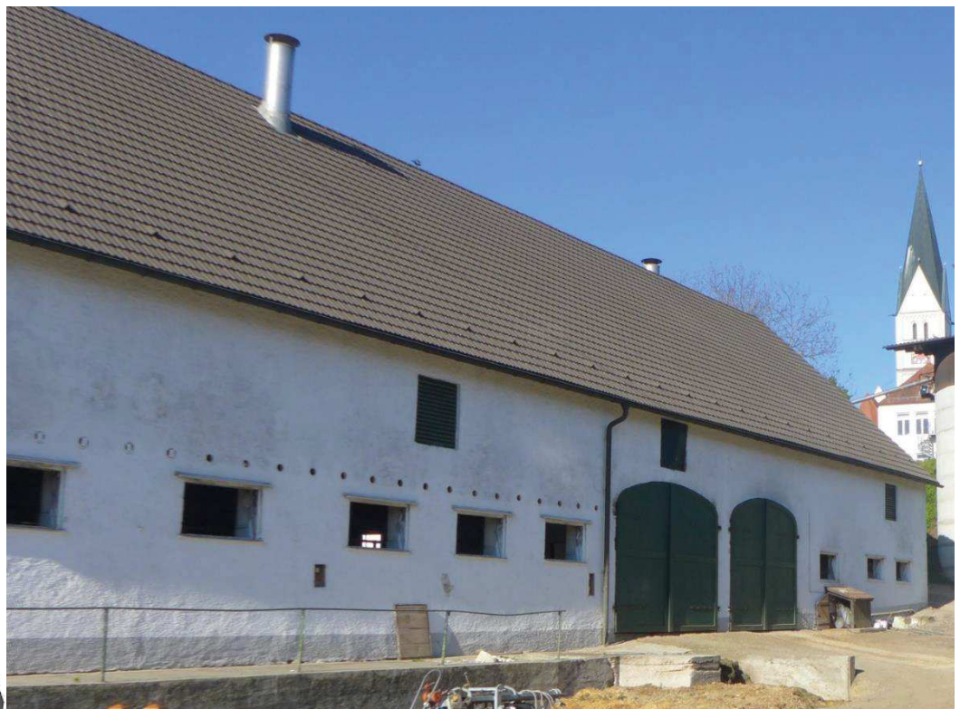
Stallgebäude an der Taitinger Straße: Bei Funktionsänderungen ist der Baukörper vielfältig nutzbar
